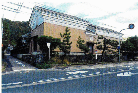
西野家西面（県道側）
