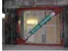
写真6 制振ブレース補強
