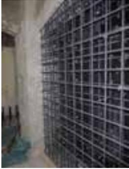
写真1 RC壁増設補強
