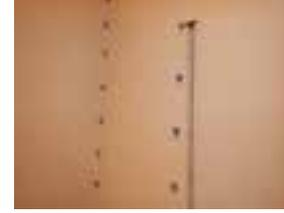
写真18 石膏ボードの釘ピッチ確認
