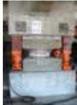
柱脚に免振装置を設置
