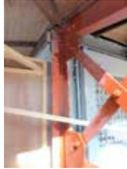
写真3 鉄骨造ブレース補強
