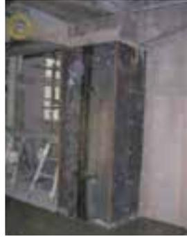
写真2 RC柱鋼板補強
