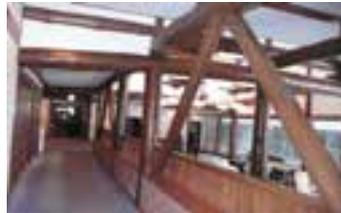
写真9 木造ブレース補強
