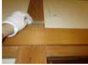
写真17 柱の傾斜確認
