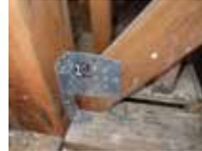
写真12 柱脚・筋交い金物補強
