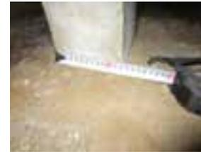
写真24 基礎の幅を確認
