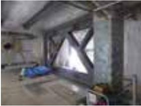
写真4 鉄骨ブレース補強
