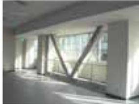
写真5 鉄骨ブレース補強 (接着工法)
