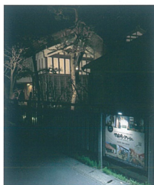
景観に寄与している置屋根真壁蔵を活用し自らの事務所とした
