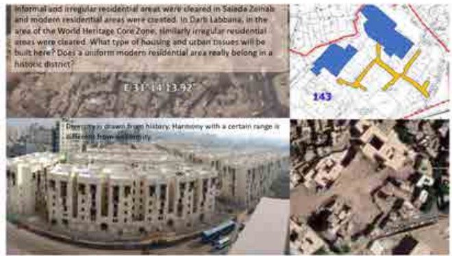
インフォーマルな地区（左上図）を撤去し新たな伝統様式を加味したアパートが建設された（左下図）。世界遺産のコアゾーンにおいて、古い都市組成（右上図）が2022年に撤去された（右下図）。
