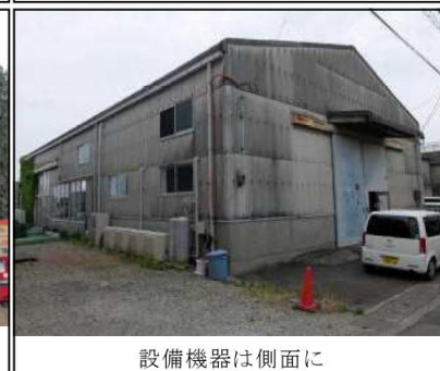
設備機器は側面に
